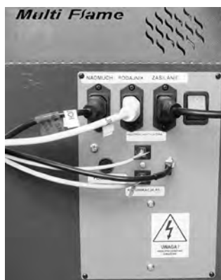
Rysunek 3 Moduł sterujący pracą palnika.
